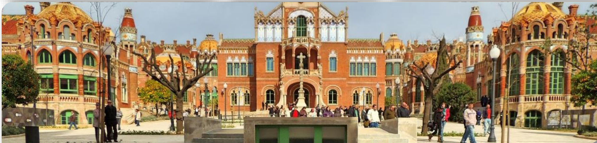
OBRA: Prefabricados Rehabilitación Hospital Sant Pau, Barcelona
