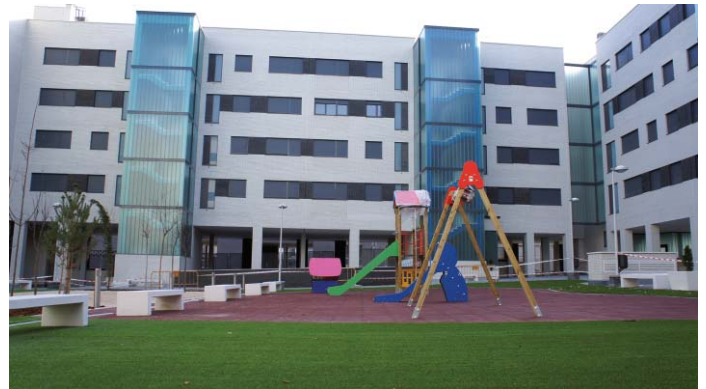
Viviendas Poza del Agua ISOLUX CORSAN Leganés
